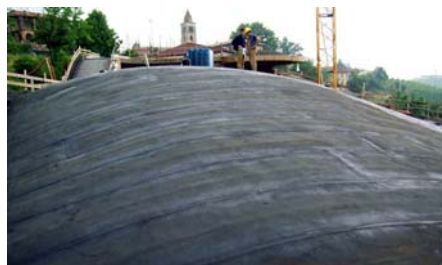
Il tetto a botte dopo la posa dell'impermeabilizzazione.
