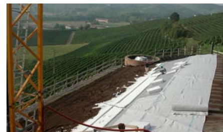
L'installazione dell'elemento di drenaggio FS 75 e del substrato.
