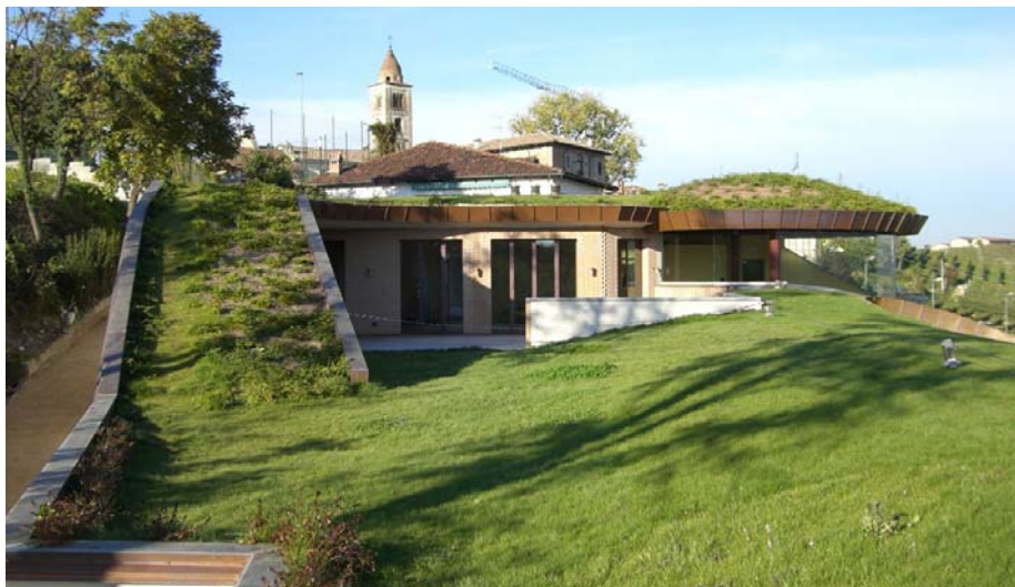
Il tetto verde sulla Cantina Ratti ad Asti, sulla sinistra una fascia realizzata con il Georaster®.
