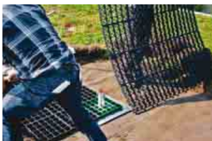
In seguito all'elemento di partenza se ne collegano altri tre in modo che il dispositivo Fallnet® SR risulti posizionato al centro.
