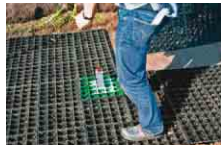
Il risultato è una piastra di ca. 5,3 m 2 , composta da quattro elementi preassemblati, per la distribuzione della trazione.
