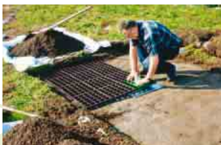
Fallnet® SR può essere installato anche a posteriori su coperture verdi già esistenti. In questo caso il punto di ancoraggio è inserito nel grigliato.
