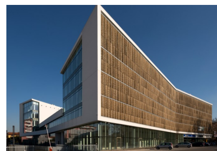
Il „sistema a lamelle“ in bambù fu costruito prevalentemente sulla parte sud come protezione dal sole.
