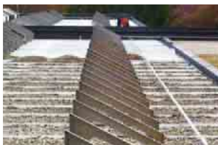
Assemblaggio dell'impianto con profilati di alluminio in una zona con carico di vento 2 e fattore "costa".
