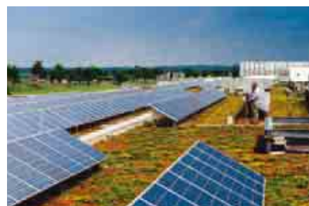
6. Tetto verde con impianto solare
