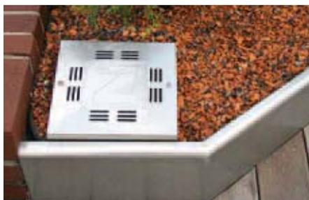
Pozzetto d'ispezione integrato nel sistema
