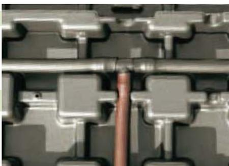
Inserimento dei tubi per irrigazione a goccia nelle scanalature apposite. Al termine si collegano i tubi con la centralina di irrigazione.
