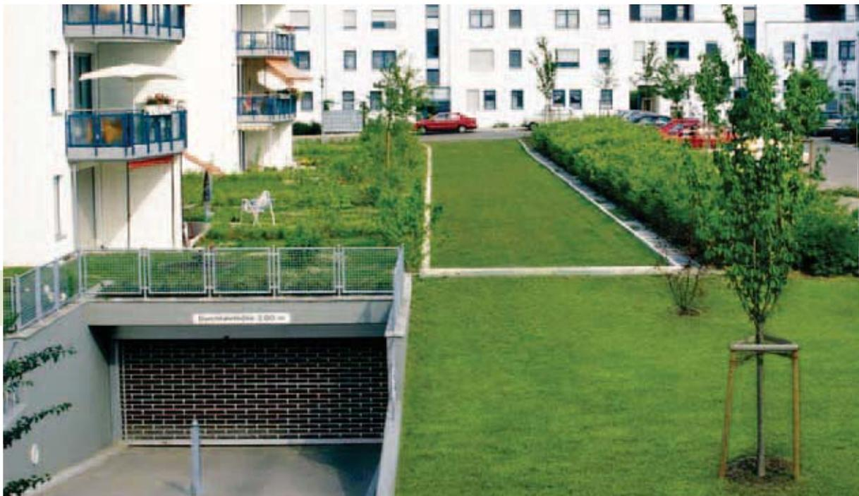
Nelle coperture di garage interrati si utilizza spesso un sistema costruttivo che consente l'utilizzo di ruspe per la stesura del substrato.
