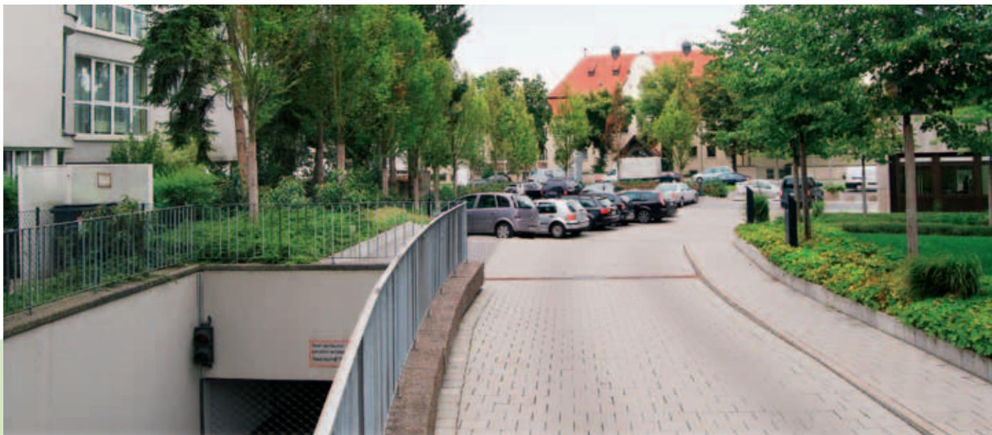
I rivestimenti carrabili sui tetti piani non richiedono solo una struttura portante. È necessario tener conto anche della portata della costruzione del tetto e dei carichi orizzontali provocati da frenate, manovre e accelerazioni. La scelta dello spessore giusto delle pietre e il tipo di posa assicurano che la pavimentazione mantenga il proprio assetto.
