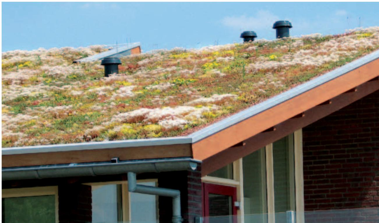
Nella maggior parte dei casi gli inverdimenti estensivi vengono realizzati sui tetti piani, ciononostante si addicono anche alle strutture inclinate. A partire da una pendenza di circa 10° occorre tuttavia modificarne la stratificazione.
