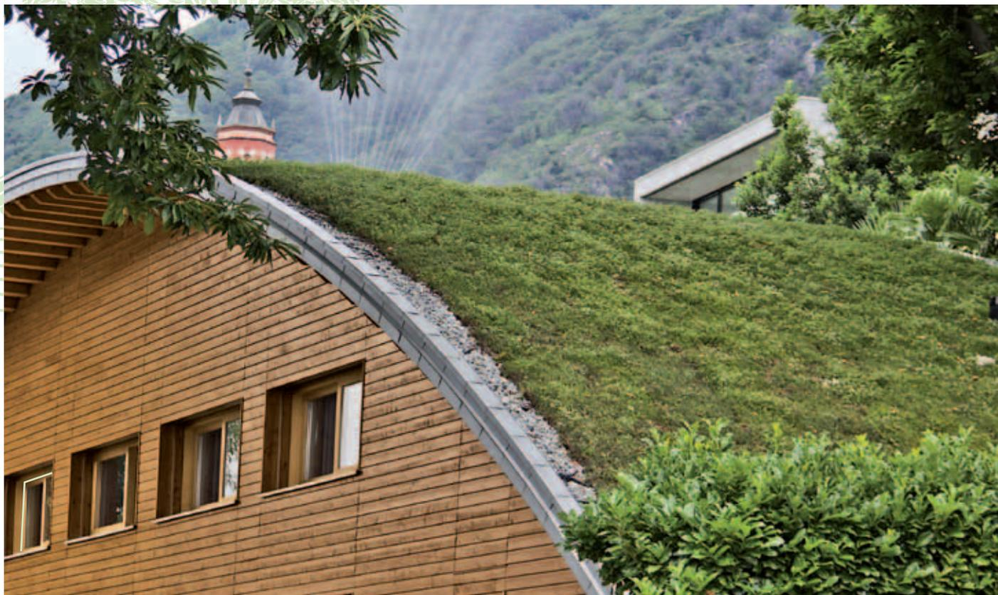
Il sistema "Tetto spiovente", basato su elementi ZinCo Georaster®, consente di installare tetti verdi con pendenze superiori a 25°. Gli elementi Georaster® sono realizzati in polietilene riciclato (HD-PE), hanno una dimensione di 54 x 54 cm, un'altezza di 10 cm e si incastrano senza richiedere l'uso di utensili, creando una struttura stabile. Una superficie dotata di tali elementi a rete è accessibile in tutta sicurezza e può essere ricoperta con Zinco terra.
