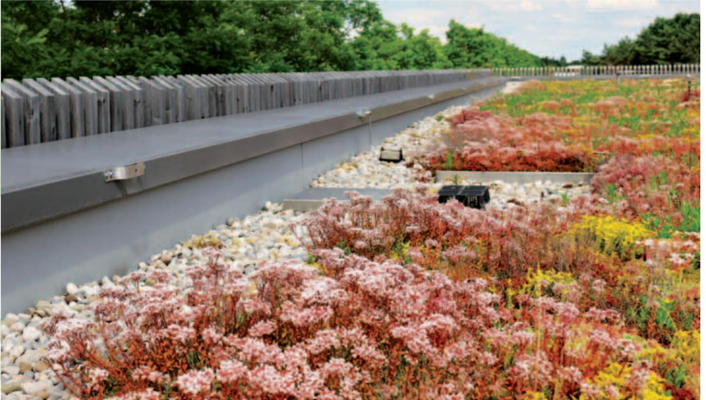
Il "Tappeto sedum" è un inverdimento estensivo con piante a crescita bassa e tappezzante che, in presenza di climi temperati su tetti piani, richiede circa 6 cm di Zinco terra "Tappeto sedum". La struttura va adattata alle rispettive condizioni del tetto. Questo tipo di copertura viene impiegato soprattutto quando è necessario intervenire con un peso minore e costi di
