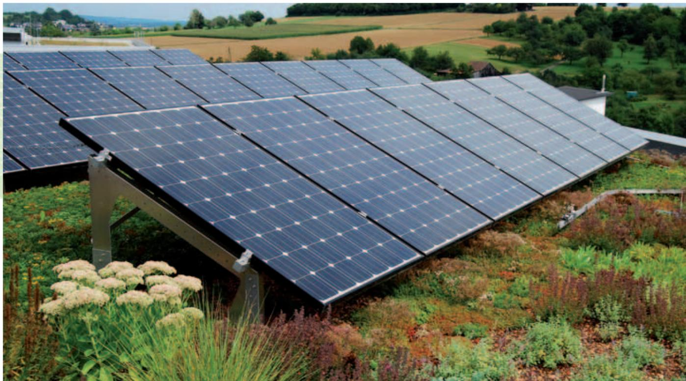
Abbinando un impianto solare con una copertura verde si ottengono sinergie importanti. Lo strato vegetativo assicura il carico necessario per contrastare l'azione depressiva del vento. Non è necessario perforare il tetto e applicare pesanti carichi quali blocchi di cemento.
