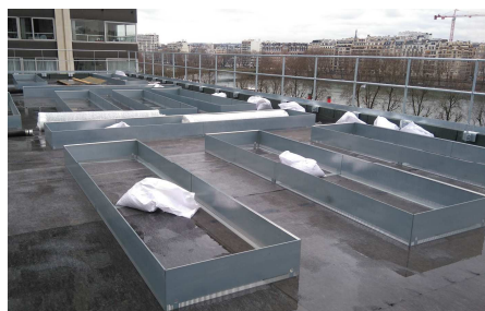
I telai delle aiuole, alti ca. 35 cm sono stati posati sopra al feltro protettivo isolante Isolierschutzmatte ISM 50.
