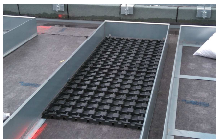
All'interno delle aiuole è stato installato un sistema con Aquatec® AT 45, all'intorno invece Floradrain® FD 40.
