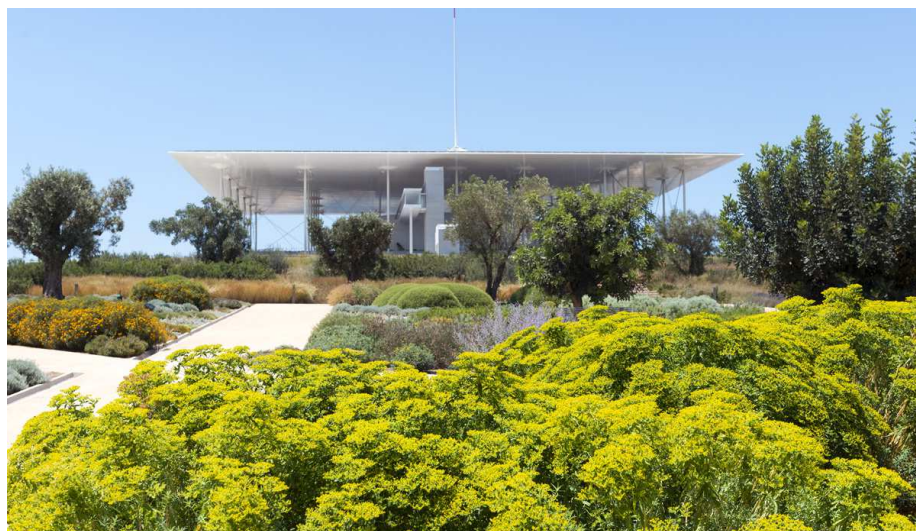
Sopra al terrazzo dell'opera si trova un tetto solare di ca. 10.000 m 2 .
