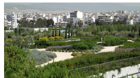
Sotto ai passaggi del tetto del garage è stato posato Protectodrain® PD 250.
