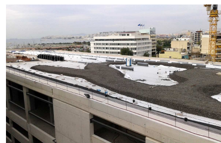
Per realizzare spessori più alti in alcune zone è stato utilizzato del vetro in schiuma frantumato.
