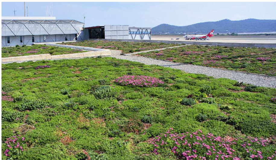
Vista sul tetto verde estensivo di grande superficie.
