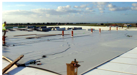
I lavori prima dell'inizio dell'installazione del tetto verde.
