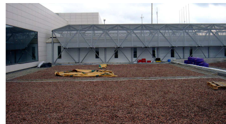
Dopo la posa del substrato in BigBag.
