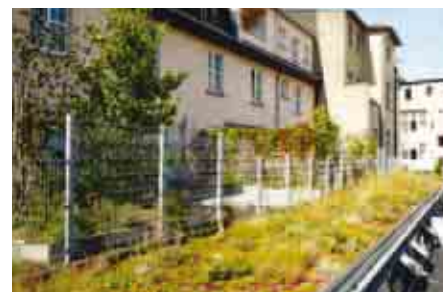
Dopo il montaggio del dispositivo Fallnet® SB 200-Rail tutto è pronto per lavorare in sicurezza lungo il bordo del tetto.
