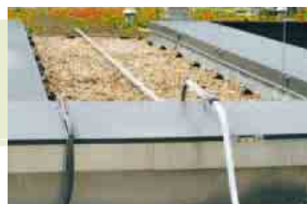
Una differenza di altezza può essere superata elegantemente con un binario a collo di cigno poiché il cursore può scorrere senza interruzioni.
