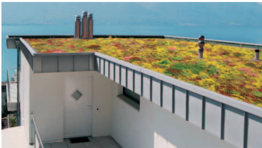
Tetto verde estensivo
