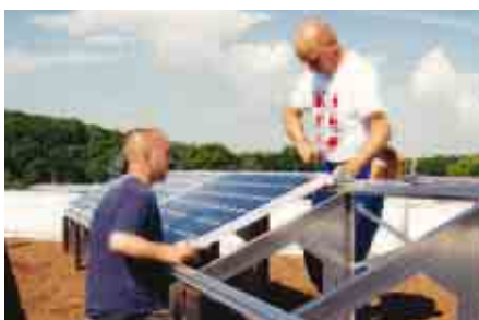
5. Montaggio dei pannelli solari
