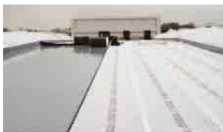
1. Copertura dello strato impermeabilizzante con il telo protettivo drenante Fixodrain® XD 20 di alta qualità
