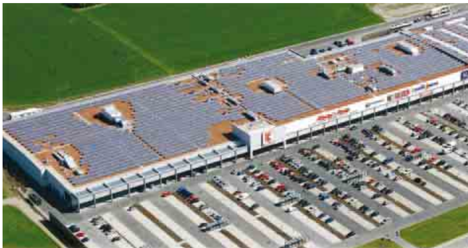
Impianto fotovoltaico sull'InCenter di Landsberg am Lech in Germania
