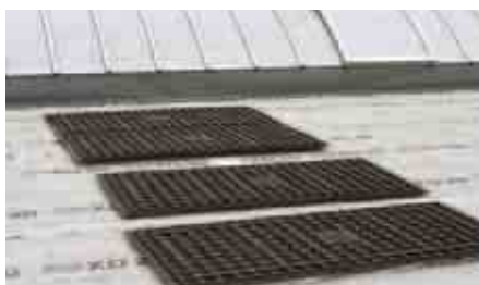
2. Posa dei pannelli di supporto ZinCo Solarbasis®
