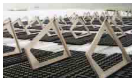
3. Installazione e orientamento dei telai di sostegno sui pannelli di supporto ZinCo Solarbasis®
