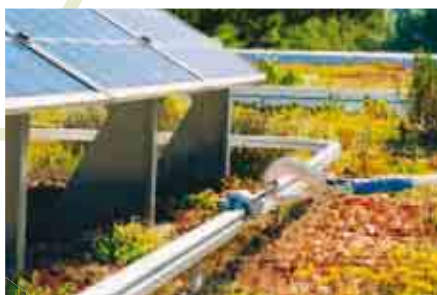
Il cursore a movimento orizzontale per l'equipaggiamento personale anticaduta è particolarmente pratico poiché dopo l'aggancio consente di muoversi lungo l'intero binario.
