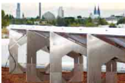
Telai con altezza regolabile per compensare la pendenza del tetto (inclinazione dell'isolamento termico).
