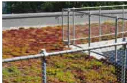
Le soluzioni parapetto di ZinCo: attrattive funzionali, con fissaggio sul tetto senza foratura della guaina impermeabilizzante!
